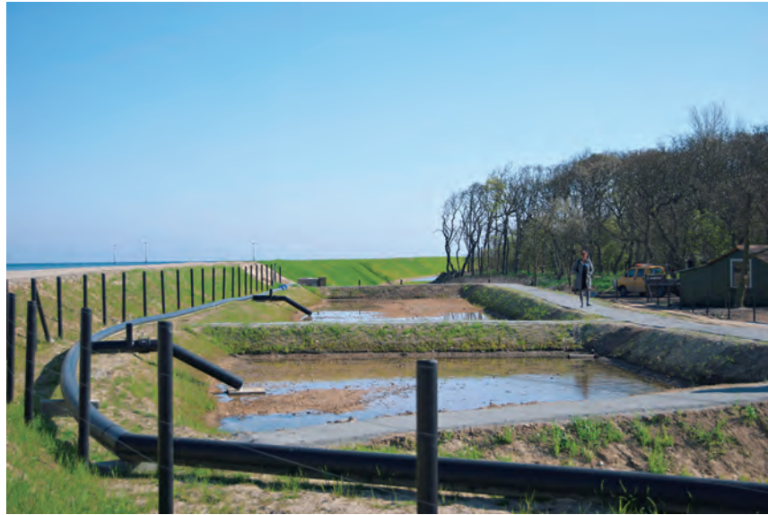
ロラン島では、沿岸防護と藻類研究を組み合わせるなど、堤防をアクティブな設備として捉え研究が進んでいる。
