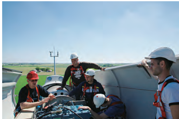
ロラン島では未来を見据え、風力発電機のメンテナンスの専門技術者を育てる世界初の職業訓練校も開校されている。
