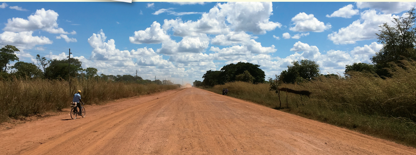
JICAの長きにわたる支援でルサカ市内の幹線道路が継続的に整備されているが、ザンビアにはまだまだ未舗装道路が多い。
