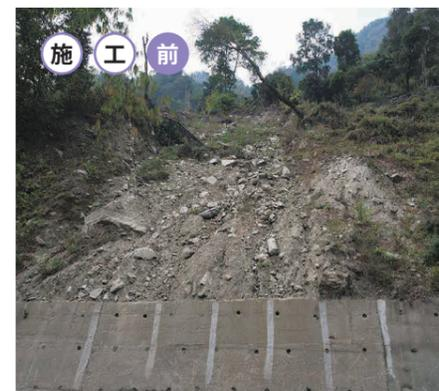
シッキム州では斜面对策を実施。左は施工前の斜面。これに対して斜面全体を覆うコンクリートの枠を設置し、上からの斜面崩壊を防いだ。右は施工中の様子。
