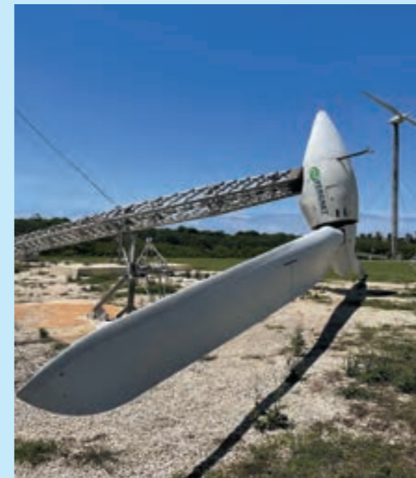
サイクロンが頻発するトンガに日本の無償資金協力で導入された風車。可倒式であり、サイクロンなどの強風時には地面に倒れて破損を防ぐことができる。台風の襲来が多い沖縄県の企業の技術が採用され、トンガにおける再生可能エネルギーの推進に貢献している。
