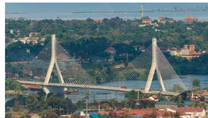
En Ouganda, un pont sur le Nil intégré au Corridor Nord a augmenté les capacités de transport. Il permet également de préserver la sécurité routière.
